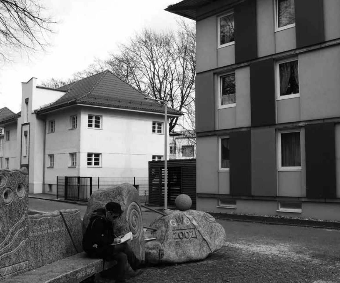
links ein renovierter Pionierbau des sozialen Wohnbaus aus der Vorkriegszeit, rechts ein Neubau der GWG in der Ernst-Koref-Siedlung im Franckviertel
